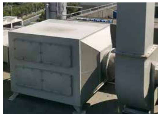
废水、废气治理设施图片
